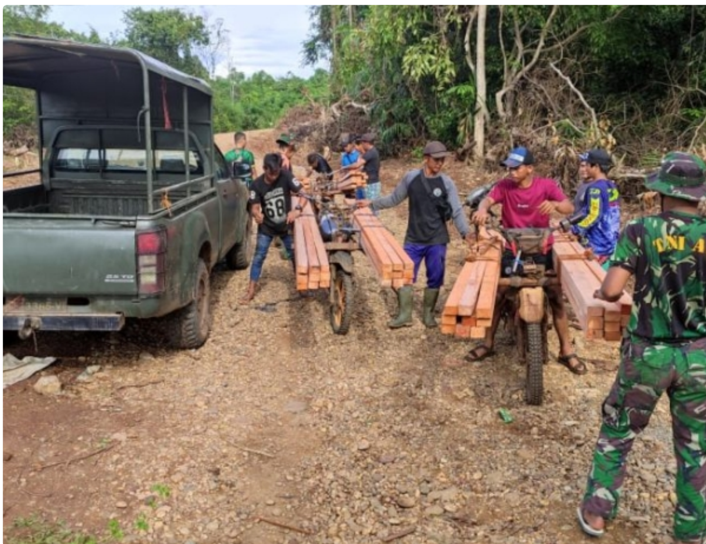
Warga Bantu Bawa Balok Kayu Untuk Jembatan
