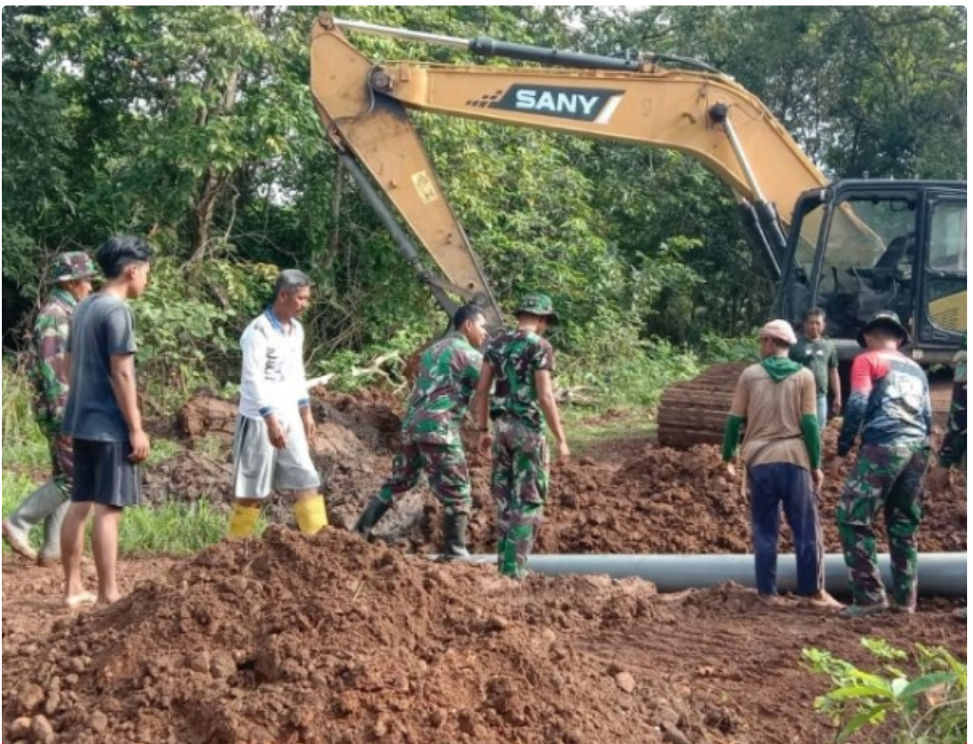
Pemasangan Pipa Saluran Air
