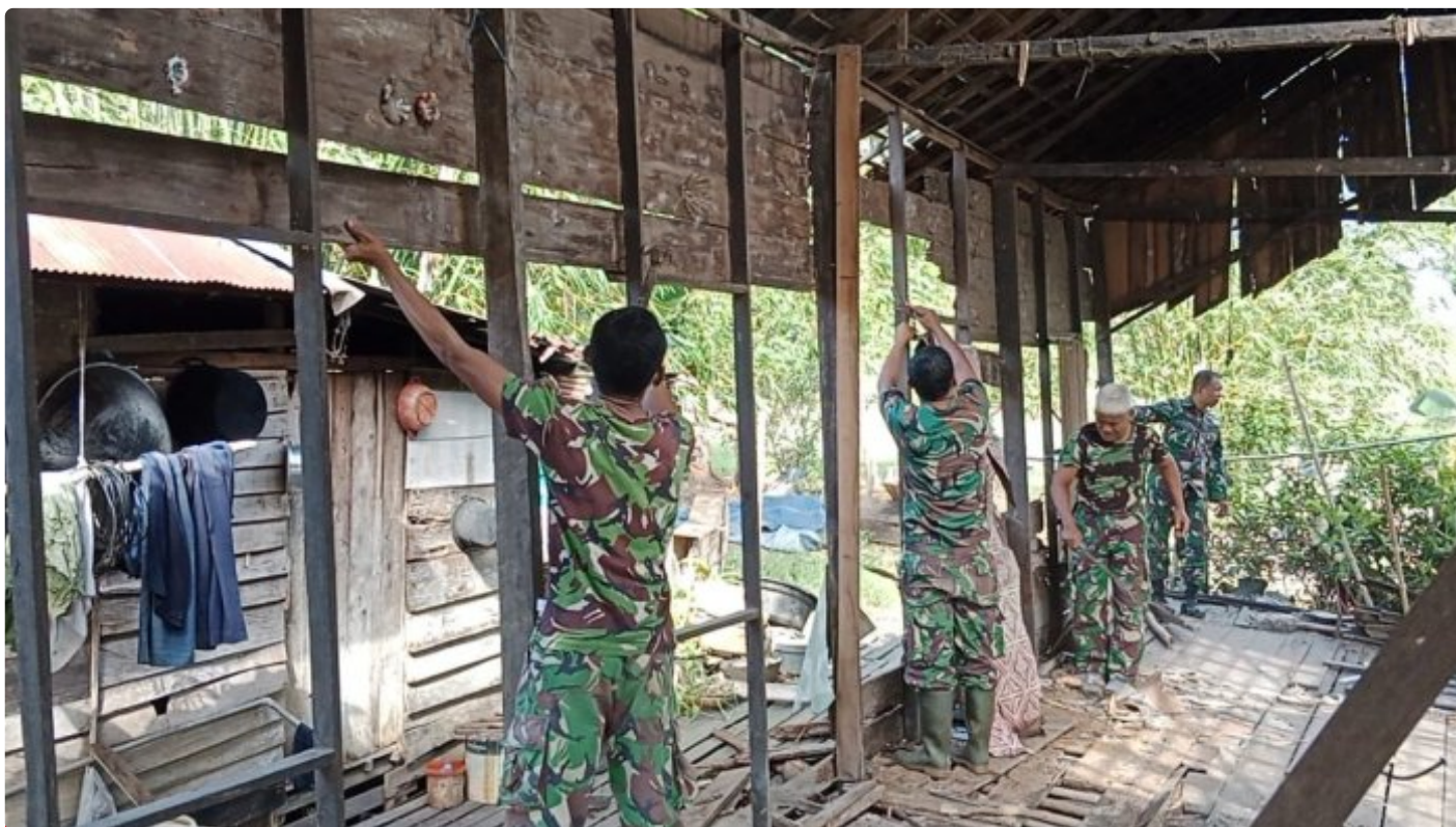
Hari ke Dua Bantuan Rehab RTLH Kodim 1006/Bjr, Bangun Tiang dan Rangka Rumah
