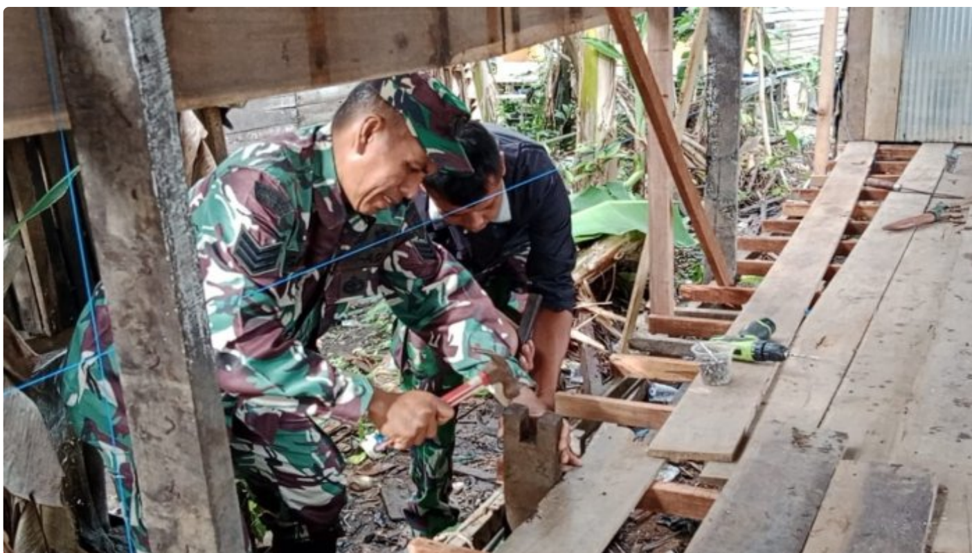
Bongkar Rumah Warga "Danramil Astambul Kini Tahap Pemasangan Lantai Kayu dan Dinding
